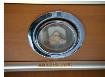
ガラスカバーを外しハロゲン電球を抜き、アルミに付けたLEDをセット
