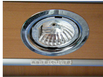
ガラスカバーを外しハロゲン電球を抜き、アルミに付けたLEDをセット
