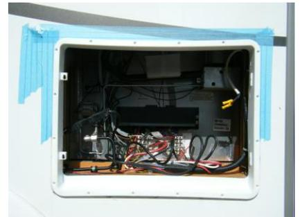
大きなガラルに合わせ切り抜く位置を罫書き、まわりを養生シジグソーでカット、枠を取付けます。
