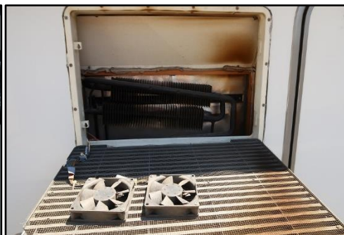
排熱効率アップ用の電動ファン
