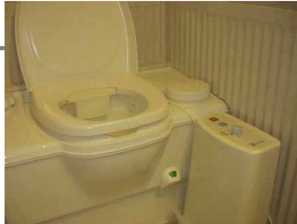
洗浄ノズル部をつけて完成
